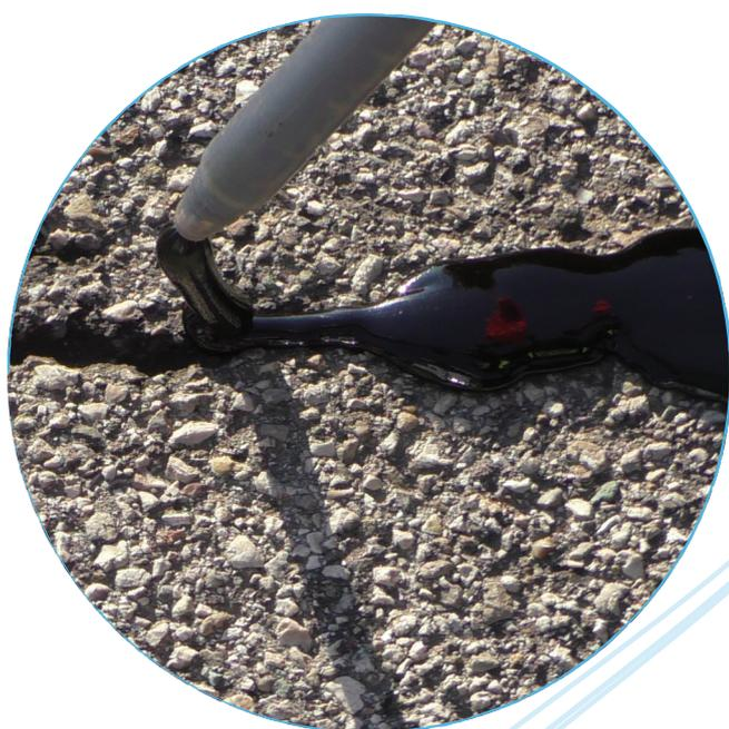
Attraverso l'uso di un sigillante bi-componente a base di bitume modificato è possibile sigillare ed intervenire nelle fessurazioni del manto stradale in conglomerato bituminoso o in calcestruzzo, per l'arresto degli ammaloramenti "a pelle di coccodrillo" e per lavori di posa e ripristino di pavimentazioni discontinue in pietra.
